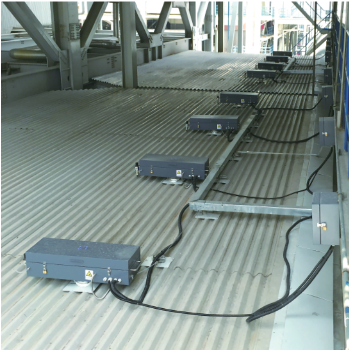
多个光学端监测喷氨优化前后A、B侧烟道的NH 3 和NO x 分布情况
